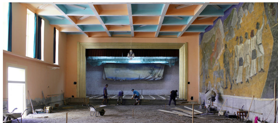
Radovi na Domu kulture
