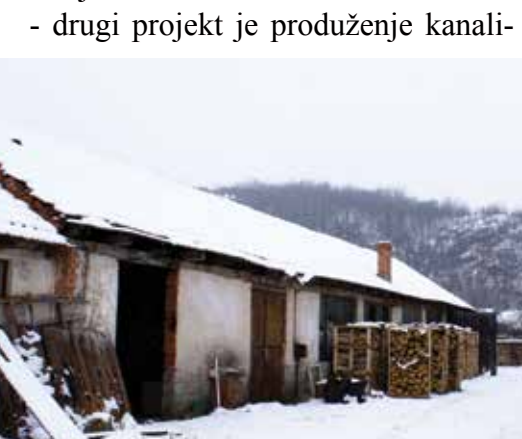
Slijedi rušenje zgrade koja već duže vrijeme nikome ne služi
