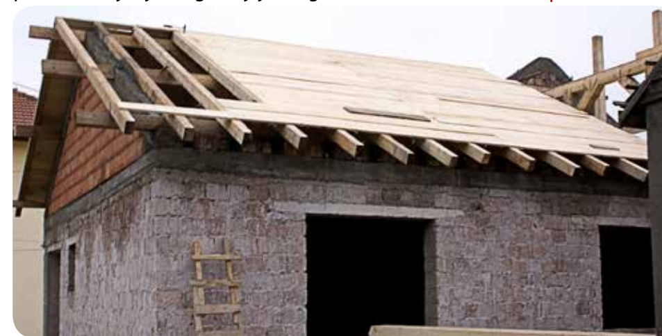
Stavlja se krov na zgradu Centra za stare osobe
