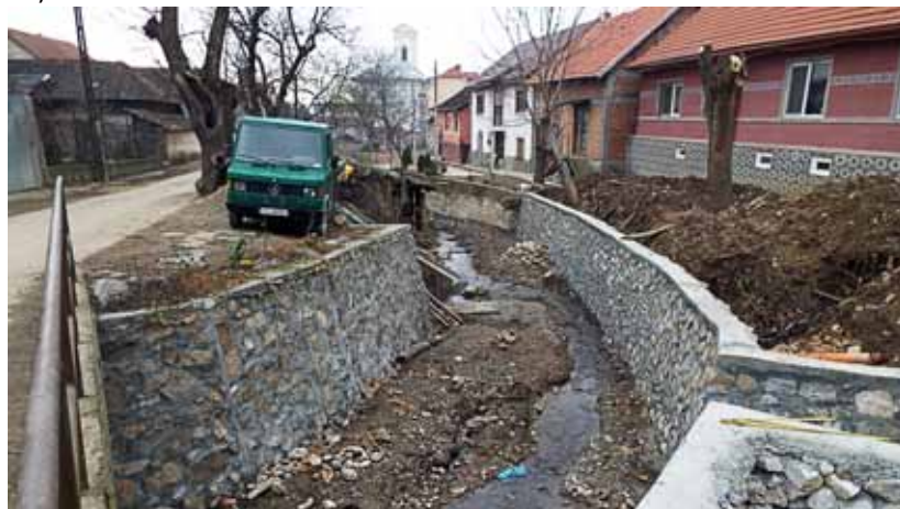
Potporni zid uz rijeku u Klokotiču
