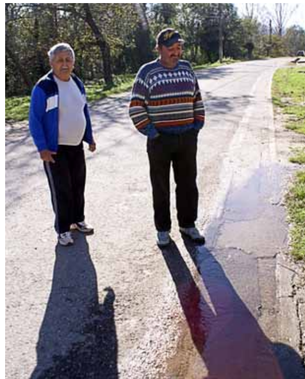
Puknula cijev na glavnom putu
